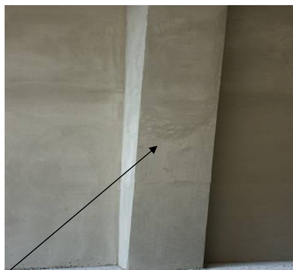
MORTIER avec FINITION LISSEE PRETE à PEINDRE
