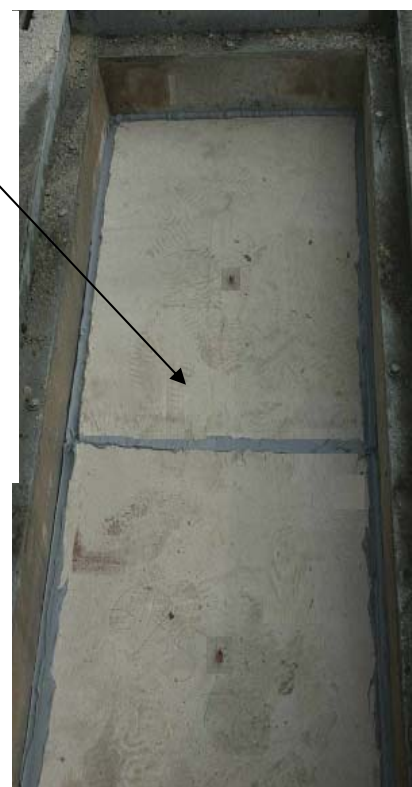
PLAQUE de 75 mm de FIRE BARRIER 135 assurant une température inférieure à 80 degrés et un Niveau N3
