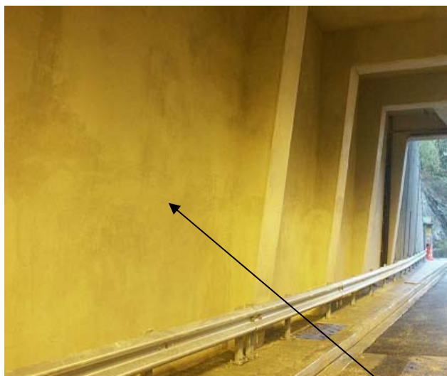
MORTIER avec FINITION LISSEE PRETE à PEINDRE
