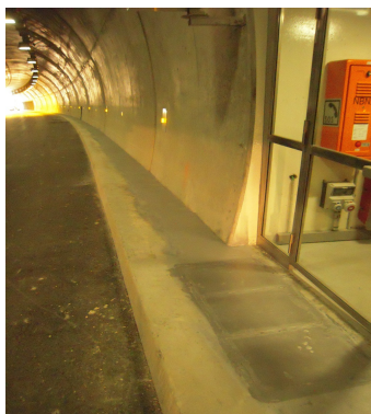
Chambre de tirage en arase
