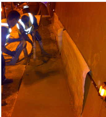
Remplissage coupe feu d'une tranchée
