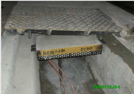
Si hauteur insuffisante sous fonte et au dessus de la chambre : Pose entre fonte et chambre
