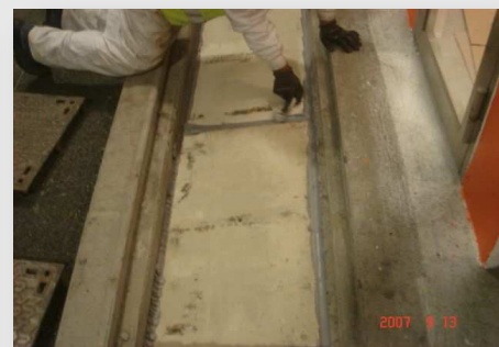
Etanchéité aux gaz et aux fumées par pose d'un mastic coupe feu
