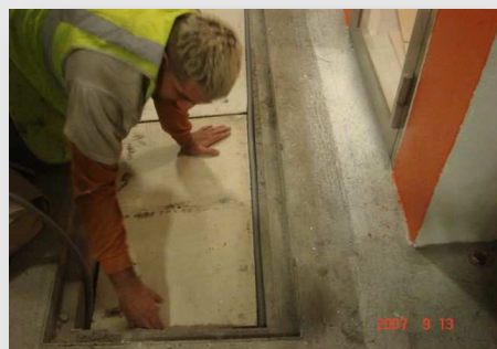
Etanchéité aux gaz et aux fumées par pose d'un mastic coupe feu
