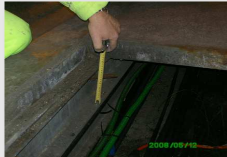
Si hauteur insuffisante sous fonte et au dessus de la chambre : Pose entre fonte et chambre
