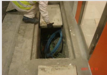
Si hauteur insuffisante sous fonte : Pose dans la largeur de la chambre
