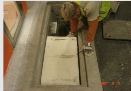
Si hauteur insuffisante sous fonte : Pose dans la largeur de la chambre
