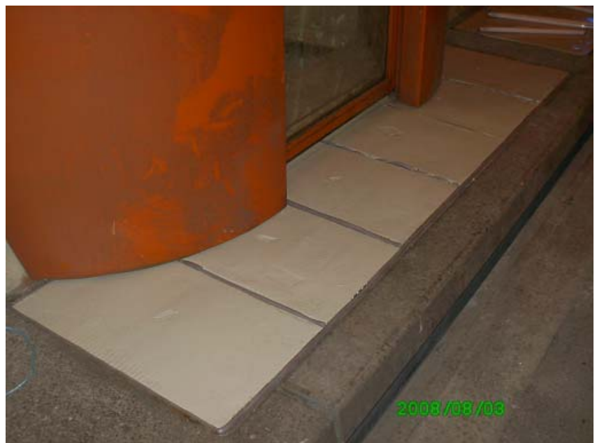
Détail des plaques au droit des niches de sécurité
