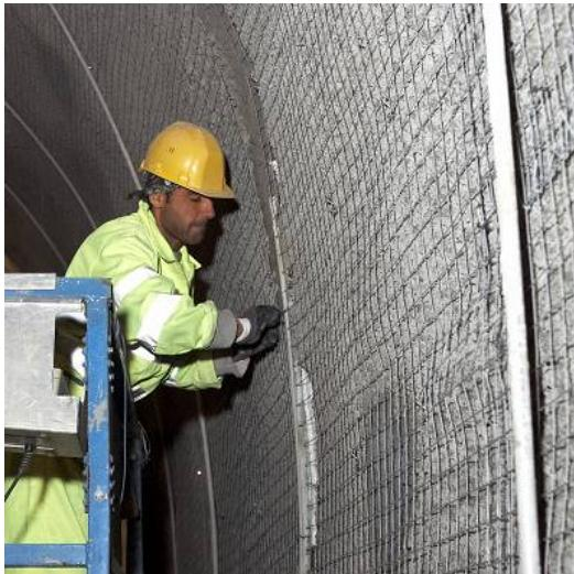
Nettinggjerdet på 50x 50x 1.9 blir installert på den påsprøytede betongen med muttere slik at den holder seg i samme størrelse som murkalken på 30 mm tykkelse som blir sprøytes på.
