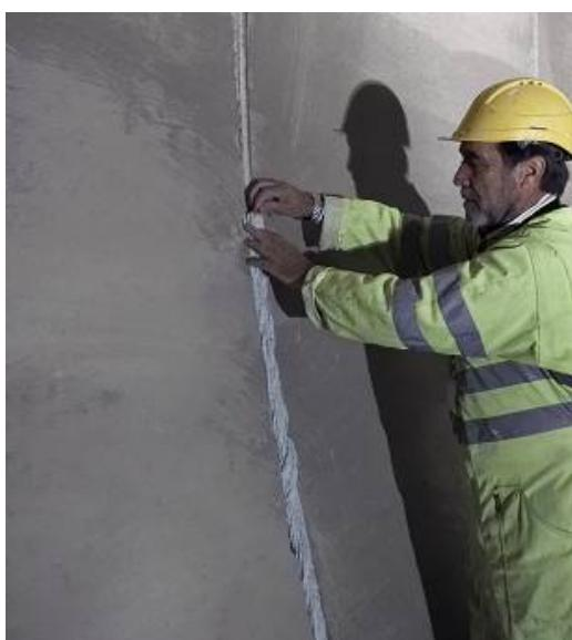
Det drenerende, ildfaste filteret som kan motstå 1425 grader, blir plassert på den påsprøytede betongen før påsprøytingen av fire barrier 135 i 30 mm tykkelse.
