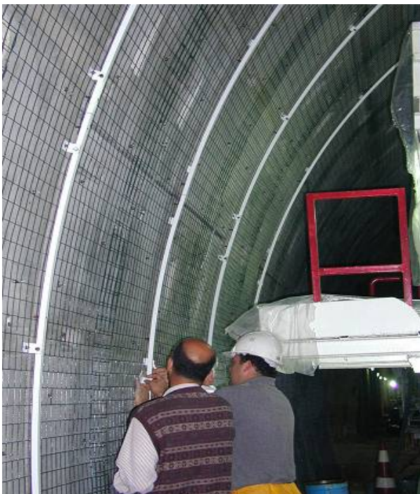
INNOVATIVE FIRE SYSTEMS – PROTECTION au FEU avec FIRE BARRIER 135 – TUNNEL de EL AZHAR
