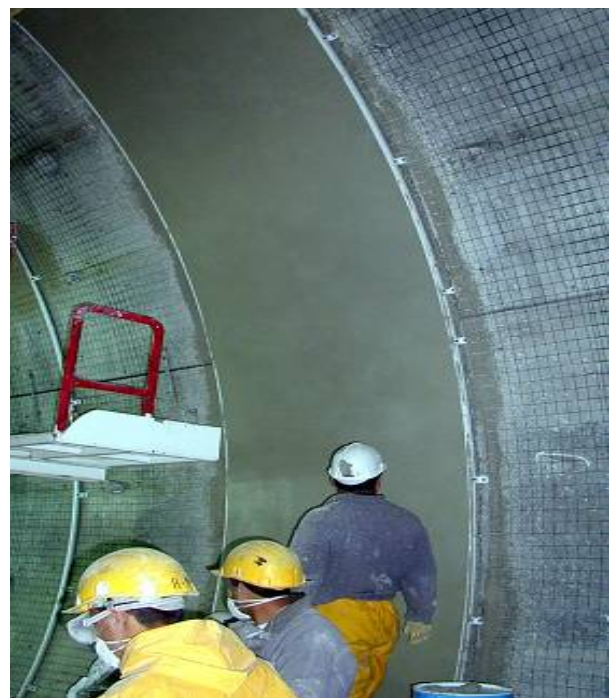
INNOVATIVE FIRE SYSTEMS – PROTECTION au FEU avec FIRE BARRIER 135 – TUNNEL de EL AZHAR
