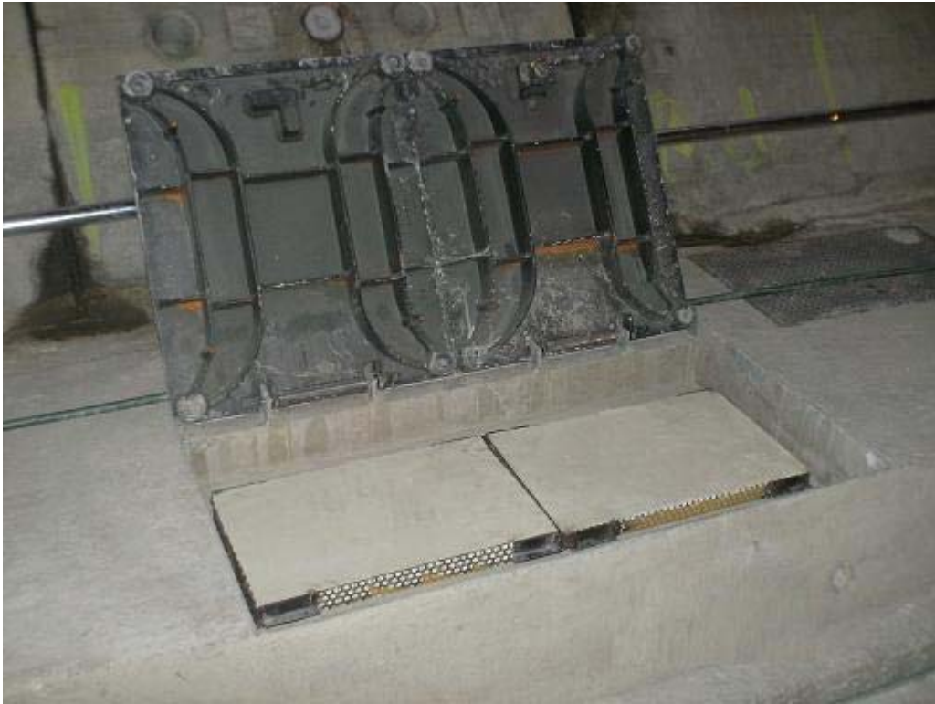
KABELZUGSCHACHT VOM TYP 2 PLATTEN 1200 X 475
