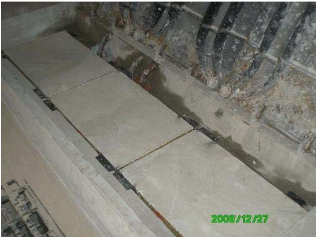
KABELZUGSCHACHT VOM TYP 3 PLATTEN 1800 X 475
